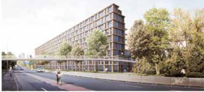
VUE DE L'AVENUE DE L'AIR
